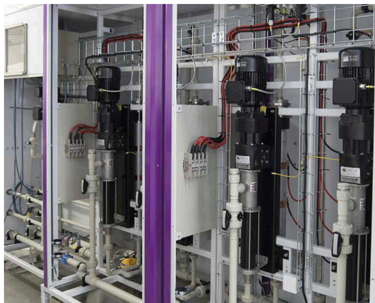
Detaljbild på en AxoPur®-anläggning
