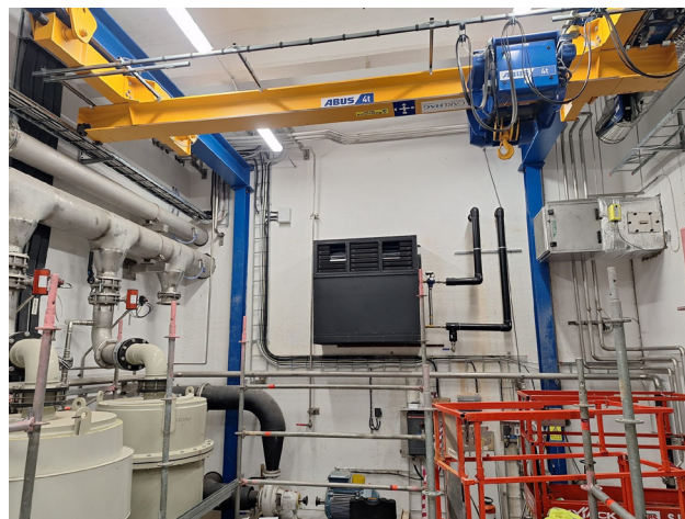
Installation av AxoPur anläggning hos Aspa Bruk, med åtta s.k. A50 reaktorer.
