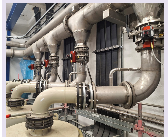
Installation av AxoPur anläggning hos Aspa Bruk, med åtta s.k. A50 reaktorer.
